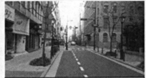
電線が地中化された三休橋筋の様子
