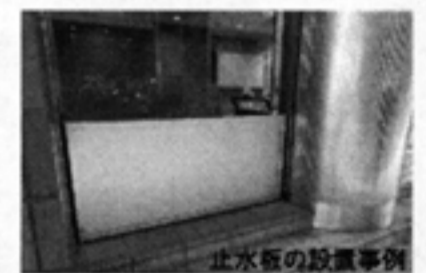
止水板の設置事例
