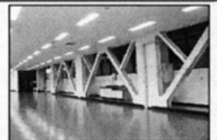
耐震改修工事の実施事例
