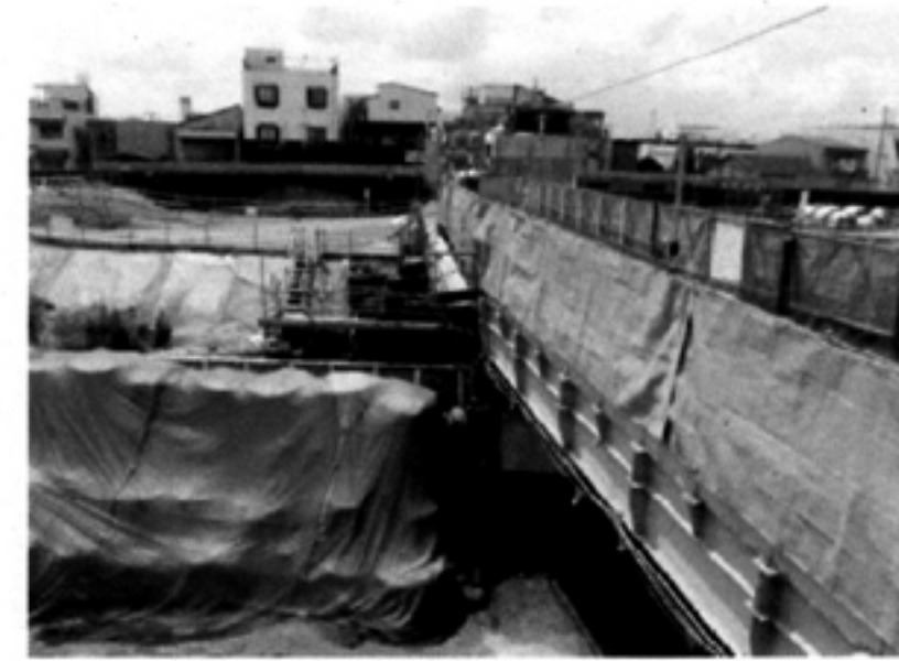
② 右岸上流より
