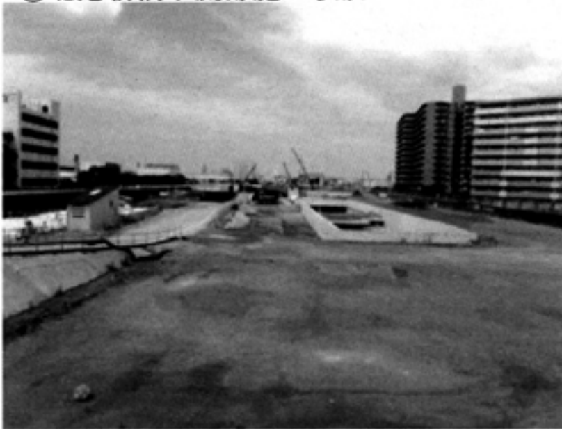
⑤北港新橋下流部施工状況
