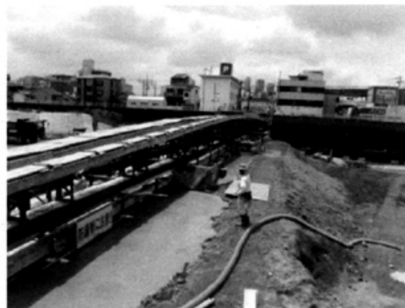
① 右岸下流より
