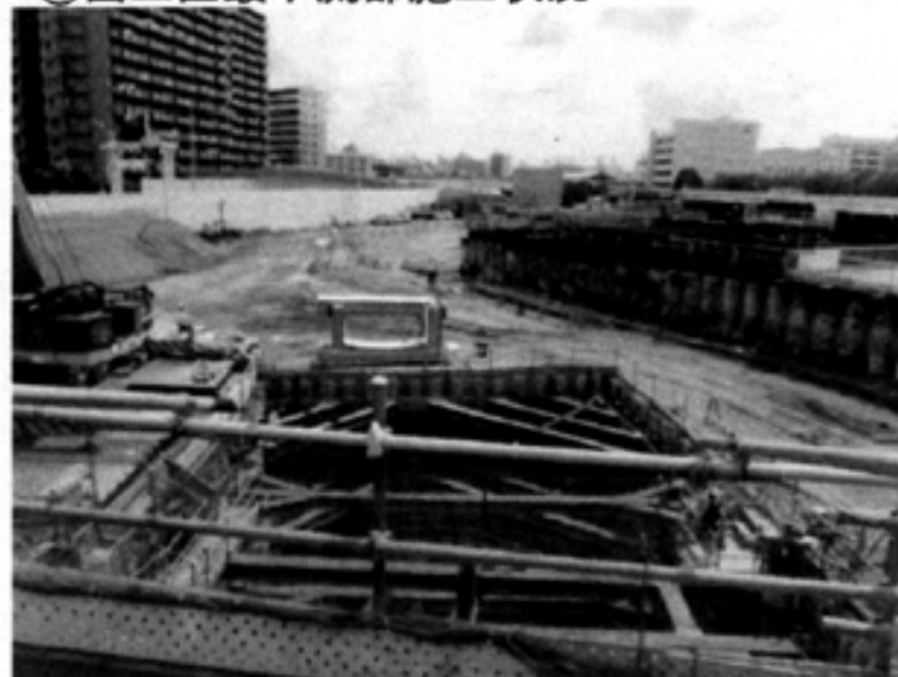
④西工区最下流部施工状況
