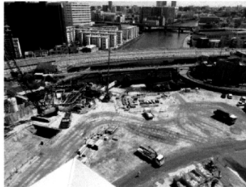
⑤最上流二重締切部施工状況
