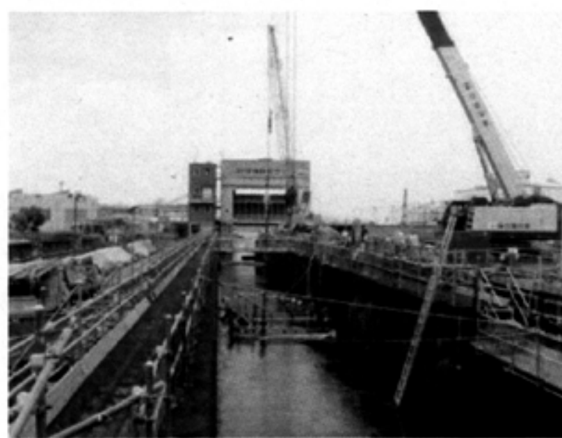
②最下流工事施工状況 上流より
