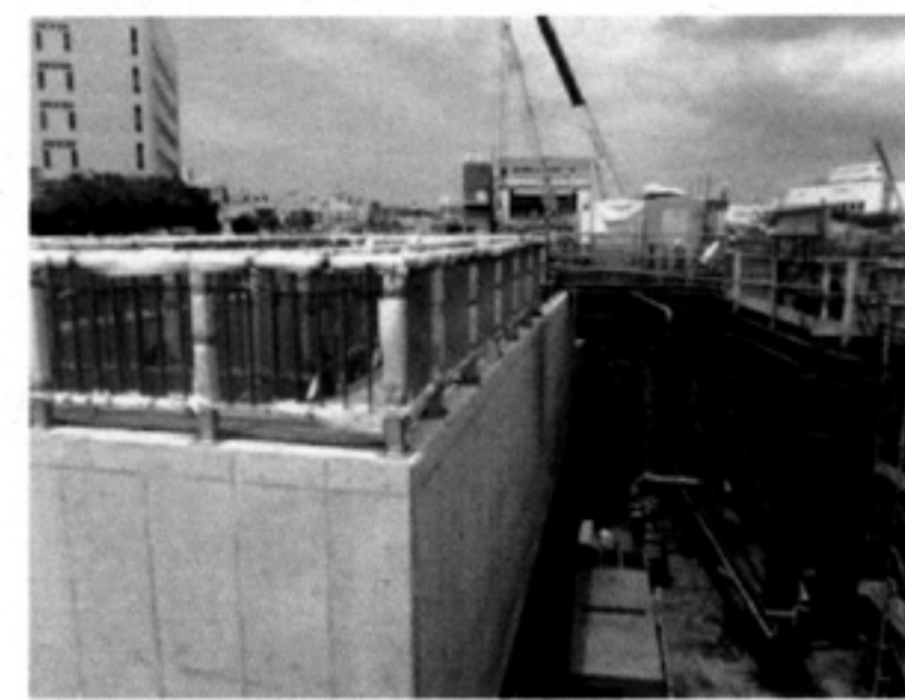
③河川ボックス立坑施工状況
