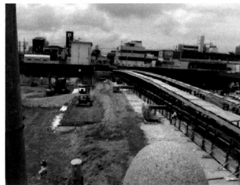
② 右岸上流より
