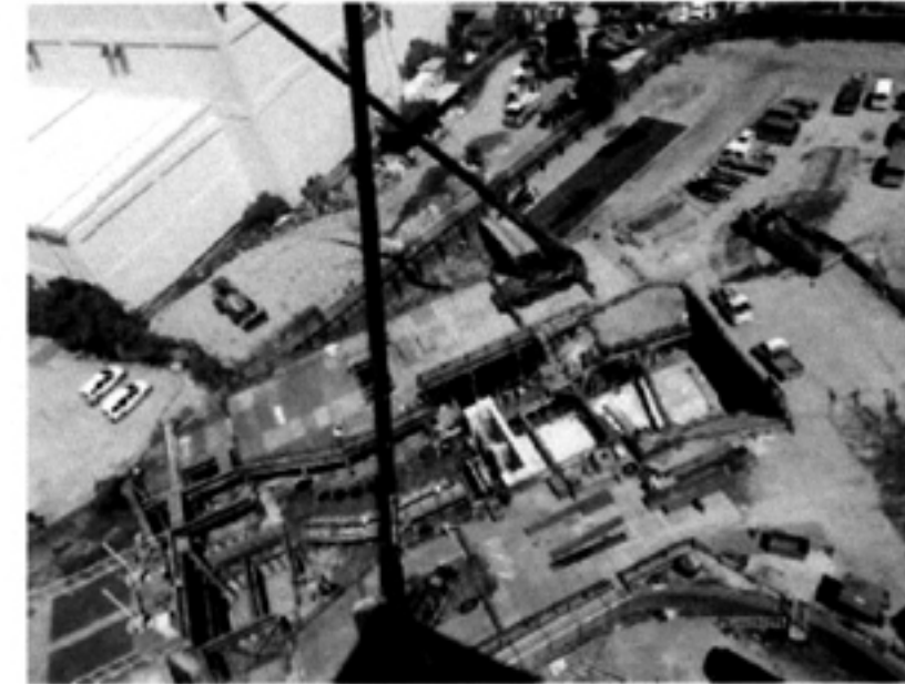
⑥最上流開水路部施工状況
