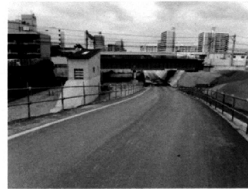
③森島橋下流部施工状況
