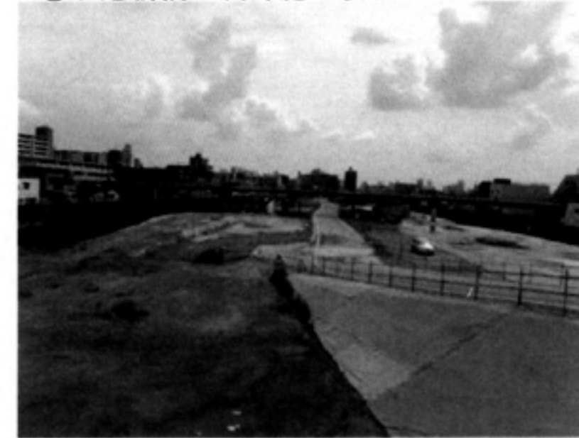
⑥北港新橋上流部施工状況
