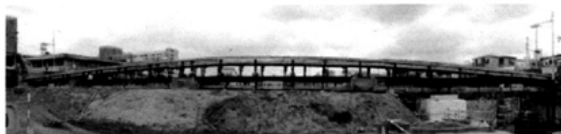
⑤ 下流より
