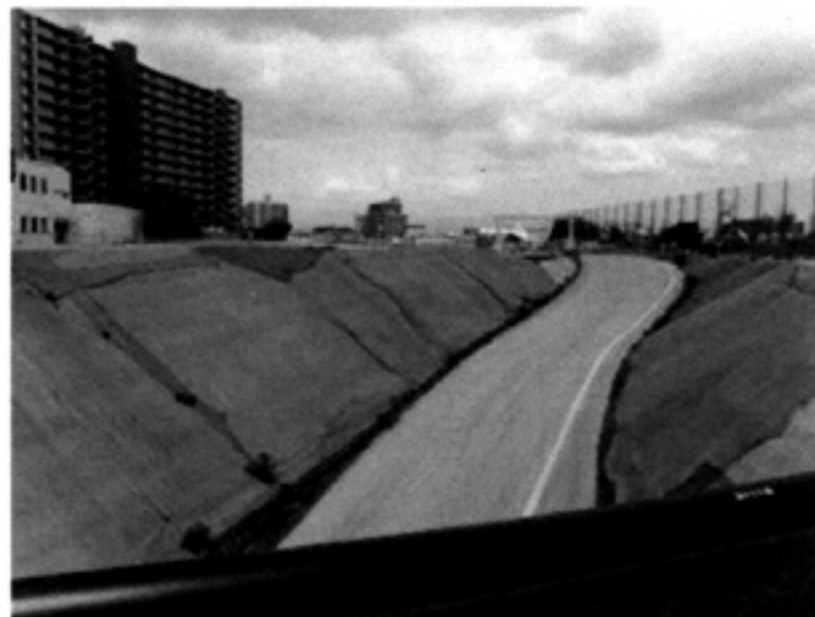
④千鳥橋下流部施工状況
