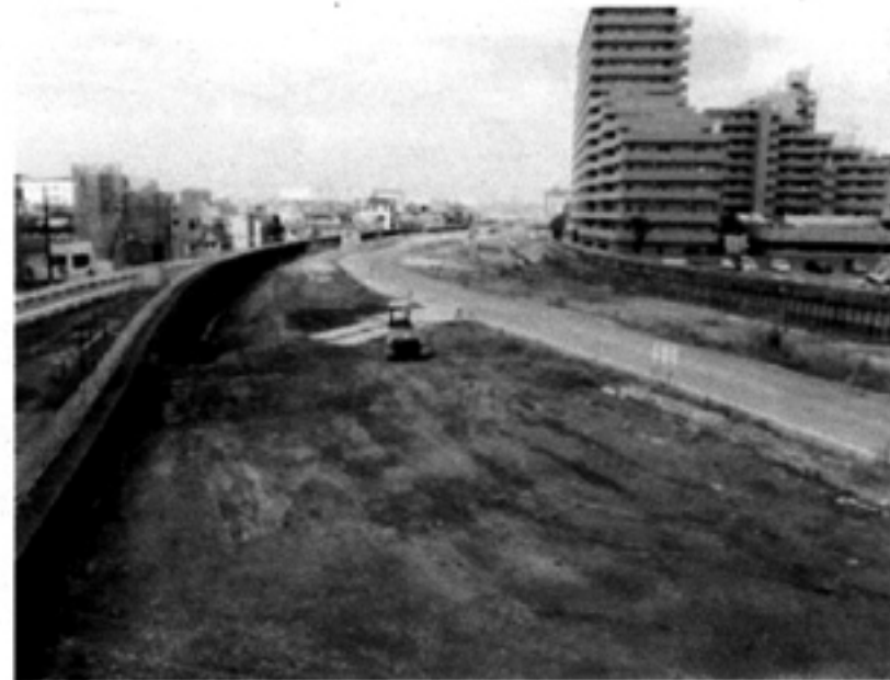
②正蓮寺橋下流部施工状況
