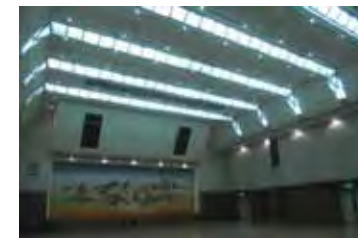
天井撤去・再設置の例 (基準に適合した天井を設置)
